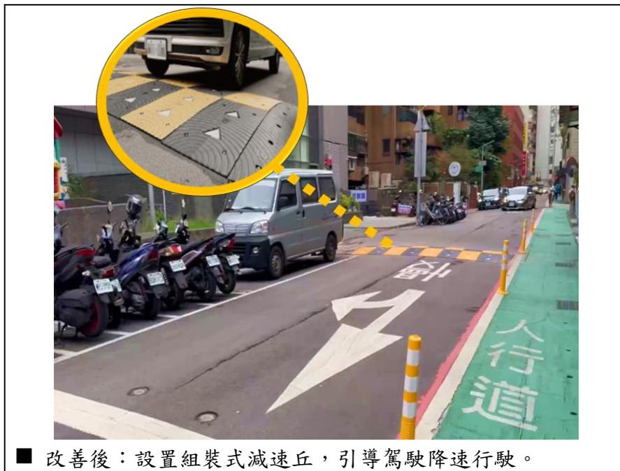
圖 7.8-4 「設置組裝式減速丘案例」設置後示意圖
